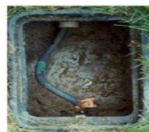
รูปที่ 5.3-23 ลักษณะหลักดิน
