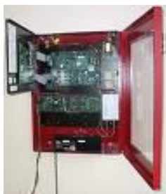
รูปที่ 5.3-25 ตัวอย่างตู้ควบคุมระบบแจ้งเหตุเพลิงไหม้
