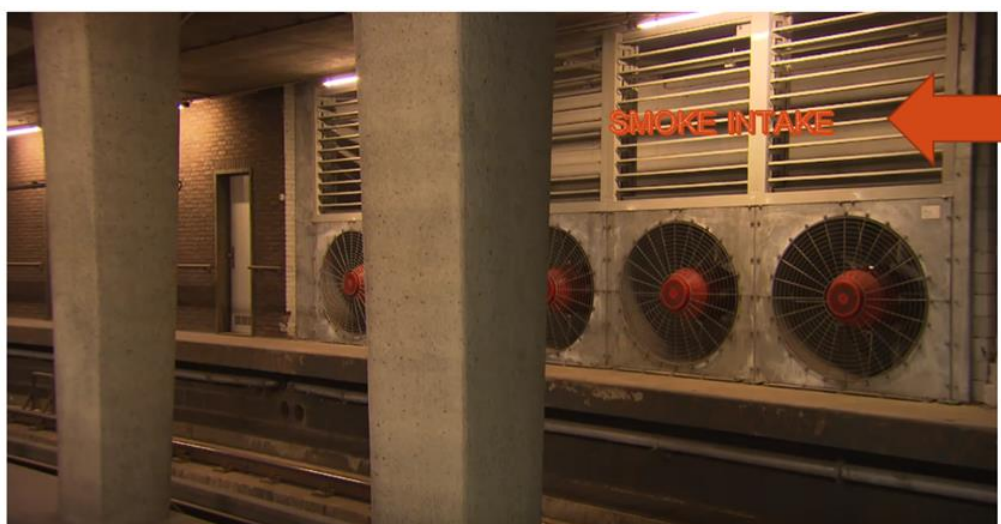
รูปที่ 5.3-34 ภาพตัวอย่างทางเข้าของควันที่ปล่องระบายควันในสถานีใต้ดินในประเทศเนเธอร์แลนด์
