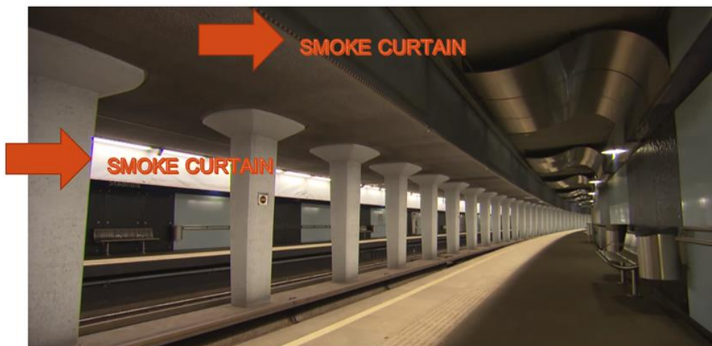
รูปที่ 5.3-33 ภาพตัวอย่างการทดสอบระบายควันและทางเข้าของควันที่ปล่องระบายควัน ในสถานีใต้ดินในประเทศเนเธอร์แลนด์
